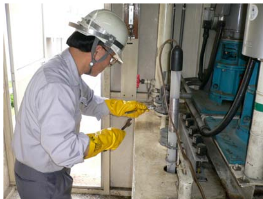
図1 酸系排ガス洗浄装置
